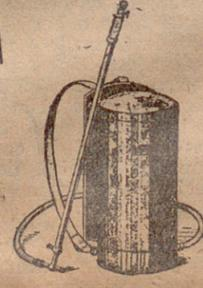
Pulverizador "LE RATIONNEL" Patenteado. Para blanquear, pintar, desinfectar, pulverizar árboles, sulfatar, etc. Pulverizadores a tracción mochila, etc.
